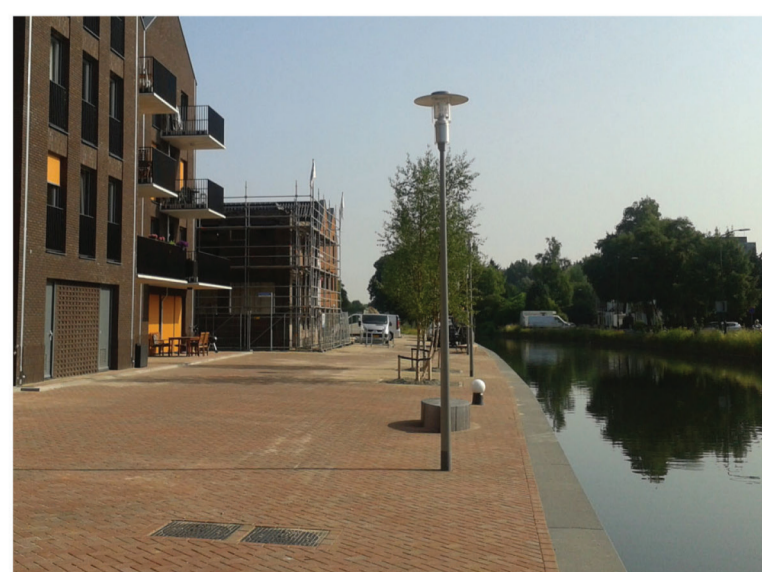
gebouwen staan direct aan de kade (beide baksteen)
