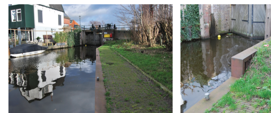
Huidige kade afwerken met een deksloof
