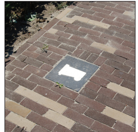
Markering opstelplaatsen mini-containers
